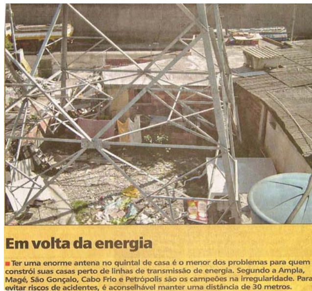
Figura 1- Habitações sendo construídas numa distância de centímetros da torre de alta tensão. Fonte: Jornal Extra 14/07/2007
